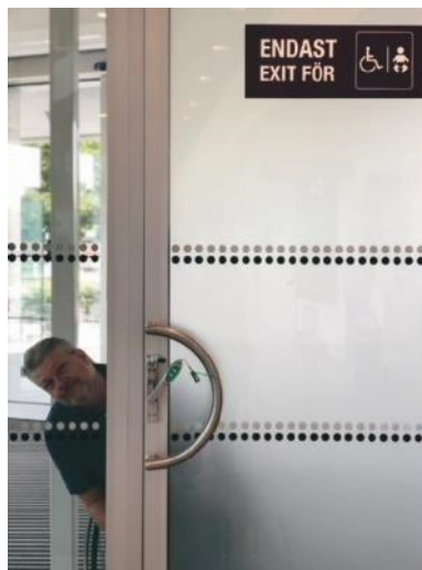
Figur 3. Juni 2018. #utanförskap, case 2. Särtänkande leder inte sällan till utpekande särlösningar. I entrén till Lunds kommuns nybyggda stadshus Kristallen finns det en snurr dörr och bredvid den en separat slagdörr utmärkt med symboler för vem som får använda den, i detta fall personer i rullstol och bebisar. Var föräldrarna ska gå framgår inte. Om skylten togs bort blev det en flexibel entré där var och en kan använda den ingång de vill. Personligen föredrar jag snurr dörrar eftersom att jag slipper att stanna upp och vänta på dörren men det finns samtidigt andra personer som tycker att snurr dörrar är obehagliga att gå igenom eller av andra anledningar föredrar vanliga slagdörrar. Foto: Bitte Rydeman.
